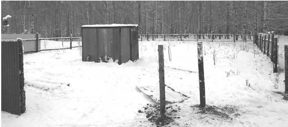
Место стройки, возводится забор
