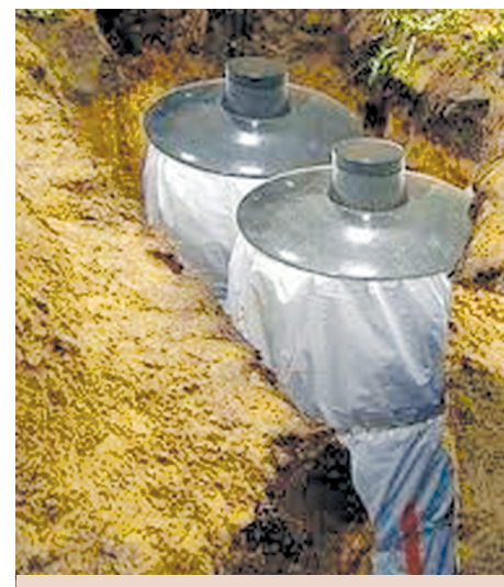
Строительство очистных сооружений
