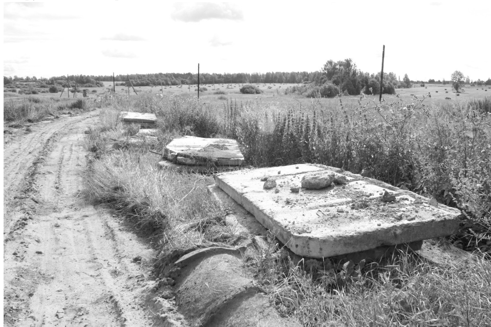
Еще недавно это было дорогой. Плиты сняты и подготовлены к погрузке
