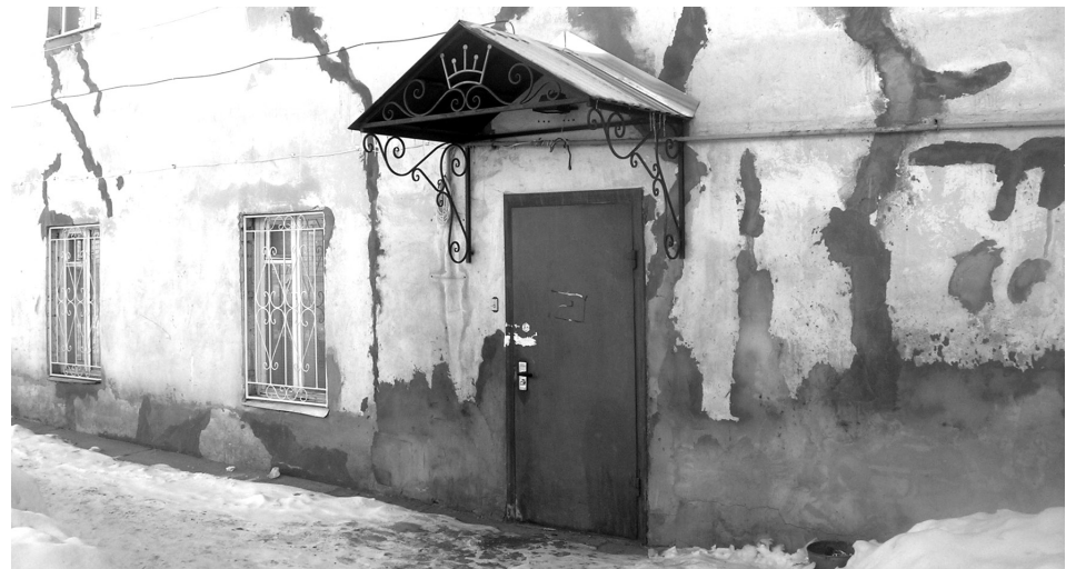
Вход в офис безымянного агентства по оказанию «информационных услуг» со двора через металлическую дверь без вывески
